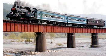
大井川第一鉄橋
